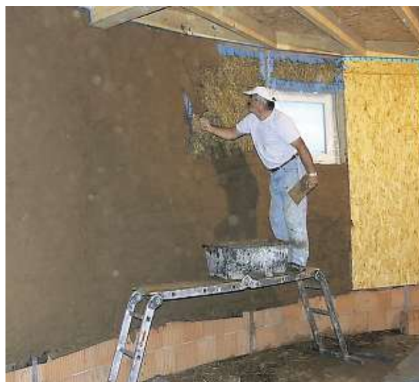
Natürliche Materialien beim Hausbau: Statt mit konventionellen Baustoffen wurde das Haus von Tilman Schäberle in Bad König aus Strohballen und Holz in die Höhe gezogen. Die Wände aus Stroh werden mit Lehmputz überzogen. Foto: shaktihaus.de
