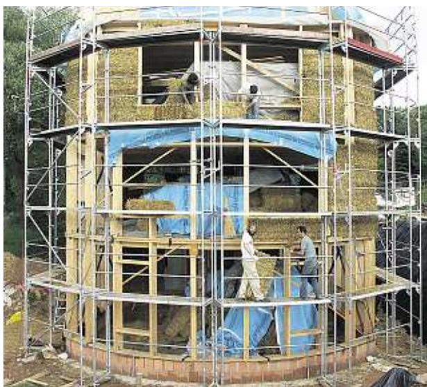
Natürliche Materialien beim Hausbau: Statt mit konventionellen Baustoffen wurde das Haus von Tilman Schäberle in Bad König aus Strohballen und Holz in die Höhe gezogen. Die Wände aus Stroh werden mit Lehmputz überzogen. Foto: shaktihaus.de
